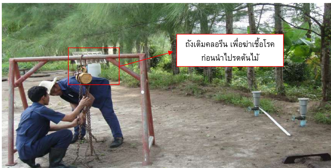
ภาพที่ 4-1 แสดงจุดการเติมคลอรีนด้วยระบบอัตโนมัติเพื่อฆ่าเชื้อโรค ในระบบบำบัดน้ำเสียของโครงการฯ
